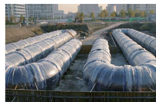
地中に埋め込まれた災害時地下給水タンク
