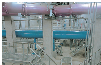
みなとみらい地区の地下共同溝
