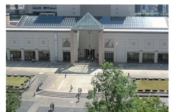
MMGCTに隣接する「横浜美術館」
