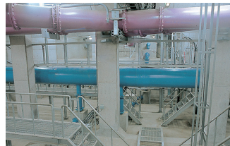
みなとみらい地区の地下共同溝
