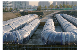
地中に埋め込まれた災害時地下給水タンク
