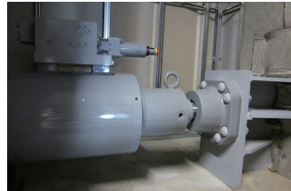
地震の揺れを吸収するオイルダンパ
